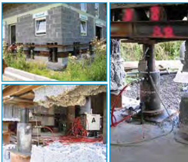
Levage synchrone avec Synchronlift pour la reconstruction des fondations d'une maison. (Allemagne 2003)
