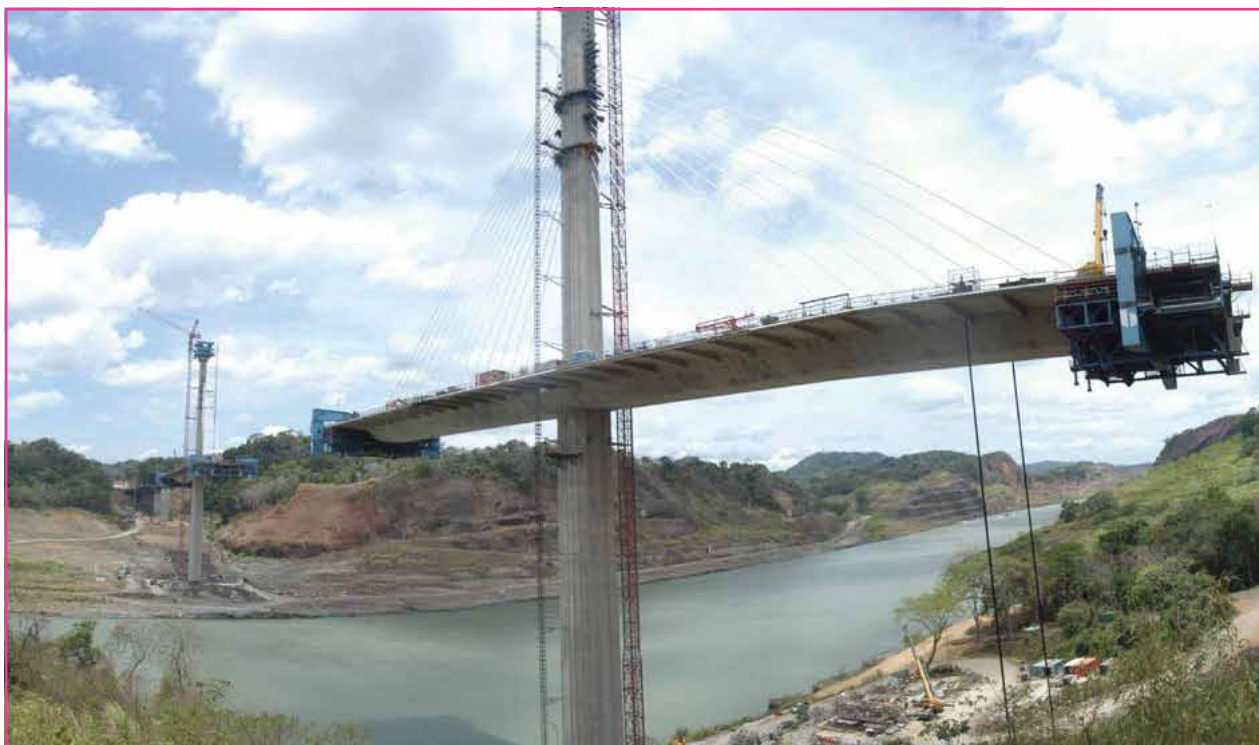
Réalisation du “Second Bridge over the Panama Canal -République of Panama” placées avec des équipements hydrauliques EUROPRESS a fournis les éléments hydrauliques qui soutiennent les segments pour la réalisation de la charpente du pont (Panama, juillet 2003)
